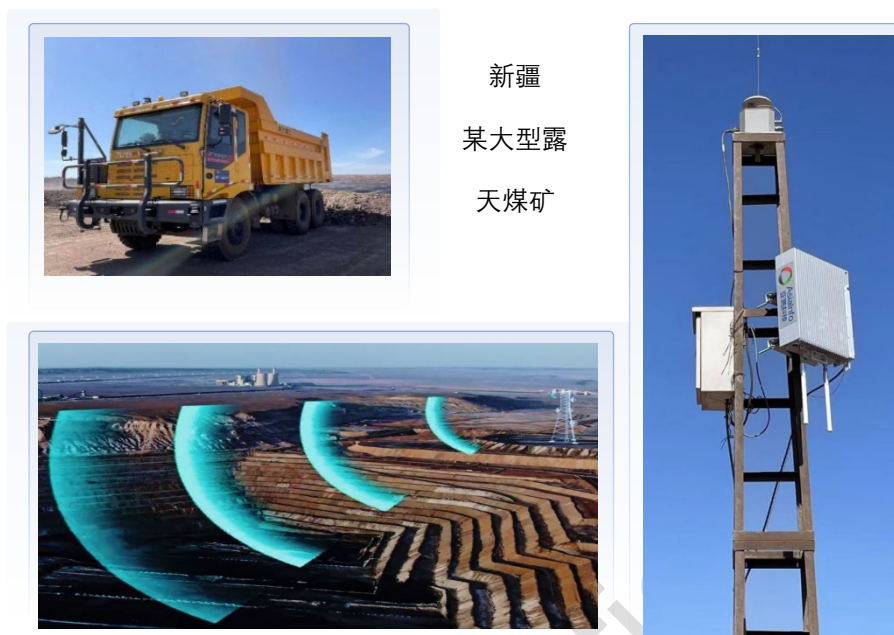
图 9-5 新疆某大型露天煤矿 5G 专网建设
